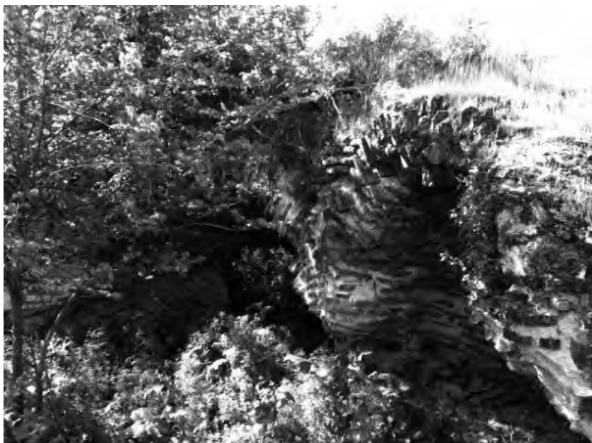
Instalaciones hidráulicas en Silillos. Prob. S. XVIII.
