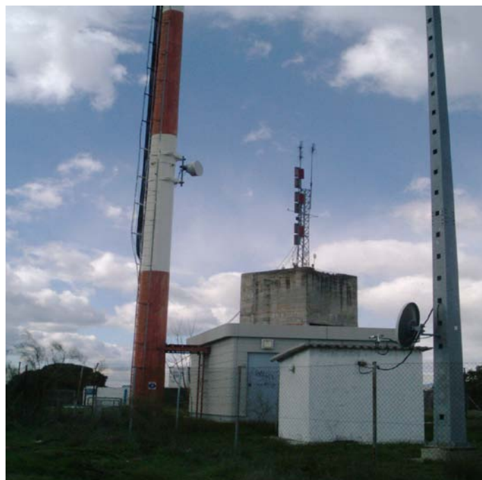
Figura nº 14. Estación base con torre soporte de antenas y caseta de control.
