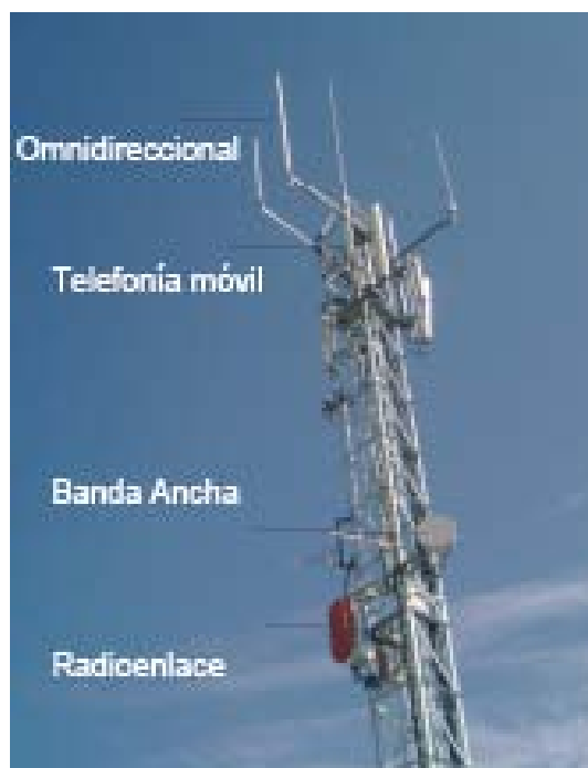
Figura nº 12. Torre soporte con los distintos tipos de antenas.
