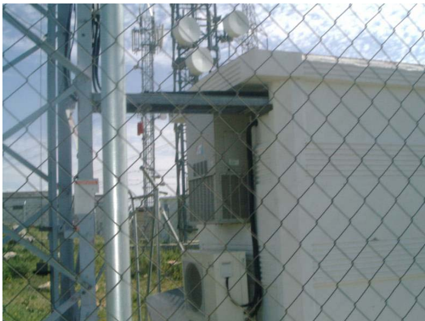
Figura nº 15. Detalle de estación base con torre soporte y caseta de control.
